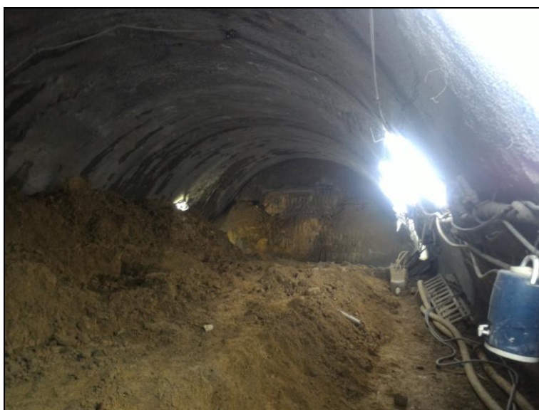
Figura 70 - Frente de escavação do túnel de via dupla
