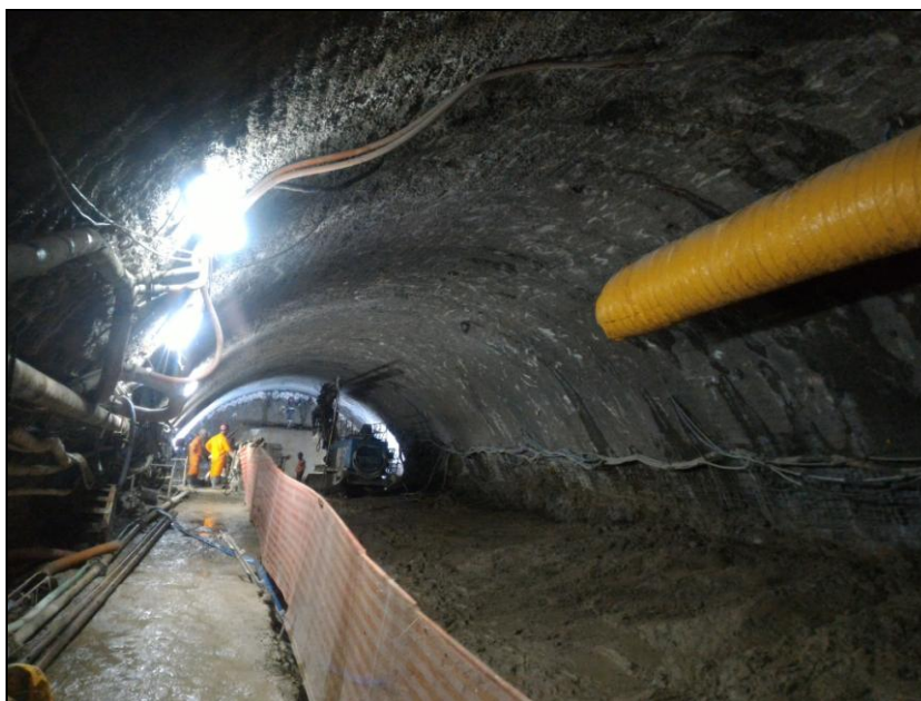
Figura 26 - Trecho do túnel em execução de enfilagens
