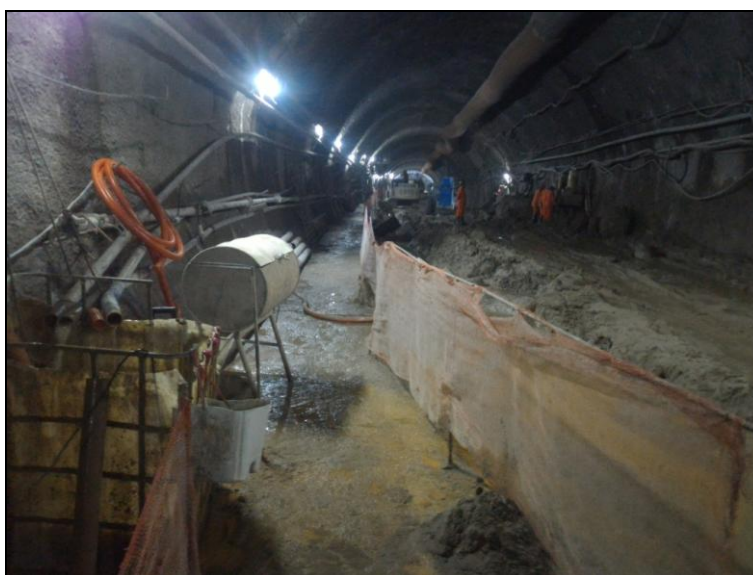
Figura 27 - Caminho seguro ao longo da extensão do túnel
