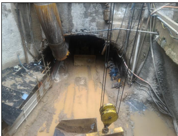
Figura 63 - Abertura de acesso ao túnel de via dupla do canteiro 03
