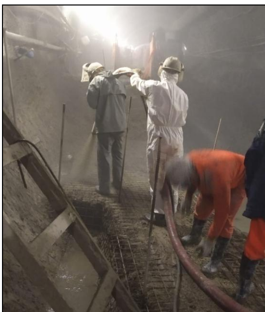
Figura 48 - Aplicação do concreto projetado
