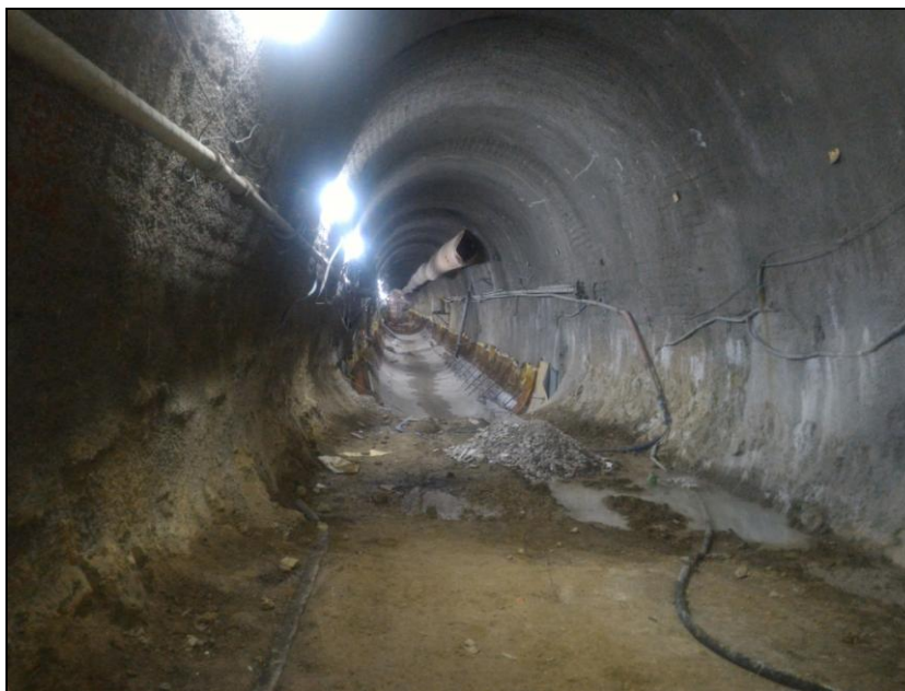
Figura 62 - Vista da frente de escavação do túnel singelo
