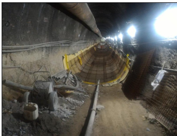
Figura 56 - Armação do arco invertido do túnel singelo
