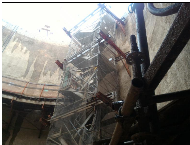
Figura 54 - Escada de acesso aos túneis
