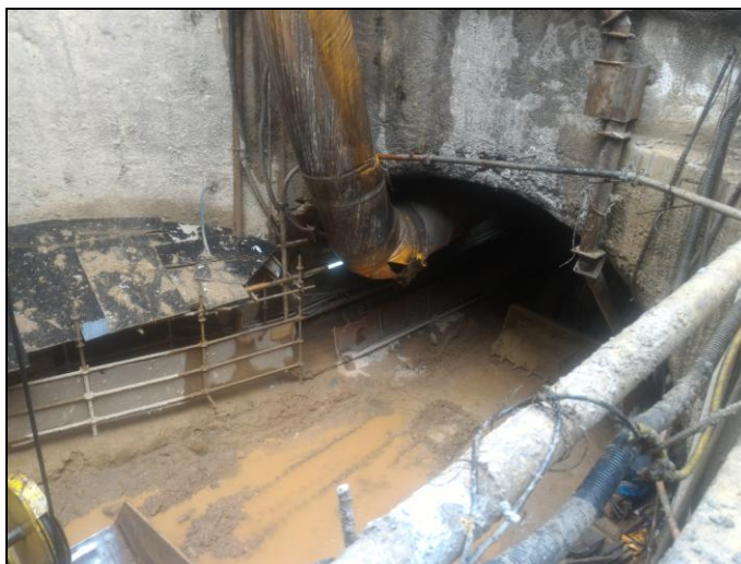
Figura 64 - Rasgo no duto de ventilação do túnel de via dupla
