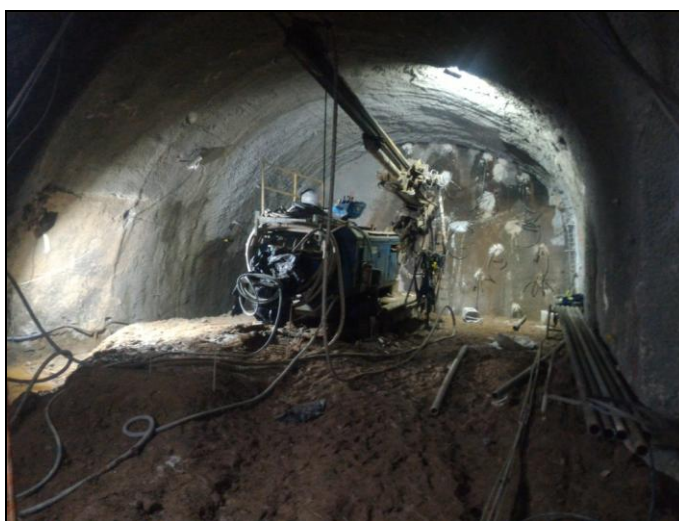
Figura 68 - Execução de enfilagens
