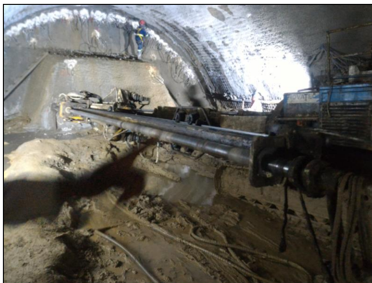
Figura 24 - Execução de enfilagens na frente de escavação
