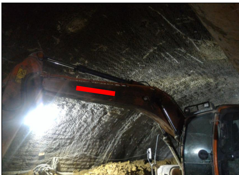
Figura 76 - Marcas de impacto da escavadeira no teto do túnel
