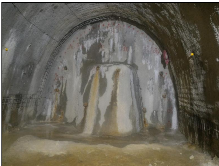
Figura 61 - Frente de escavação paralisada do túnel singelo
