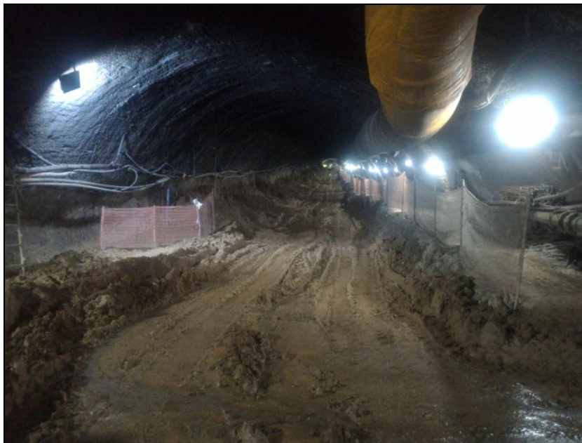
Figura 77 - Caminho seguro ao longo do túnel
