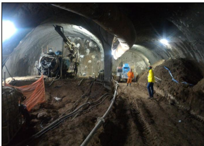
Figura 67 - Frente de escavação em dois túneis parciais
