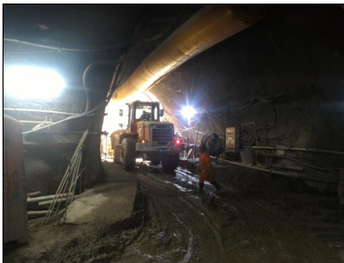
Figura 29 - Pá carregadeira para remoção de solo na entrada do túnel
