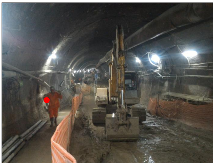
Figura 28 - Caminho seguro segregado da via de circulação das máquinas
