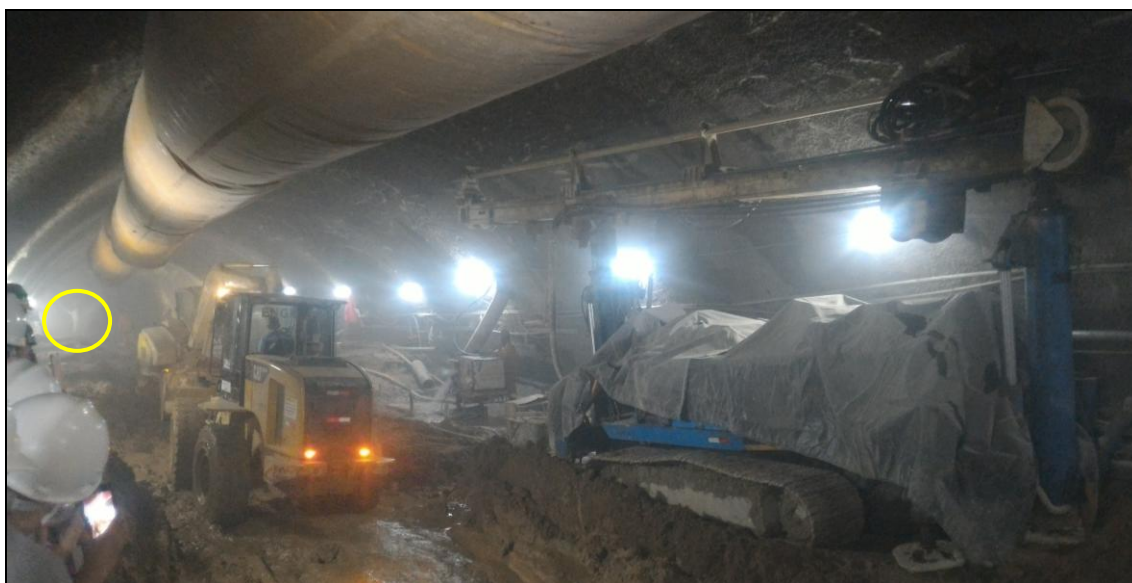
Figura 46 - Indicação do trabalhador aplicando o concreto projetado
