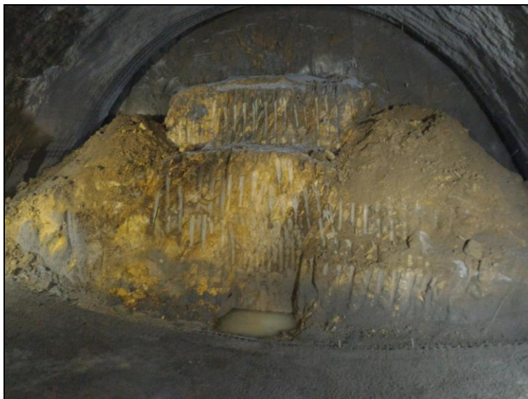
Figura 71 - Frente de escavação após concretagem do arco invertido
