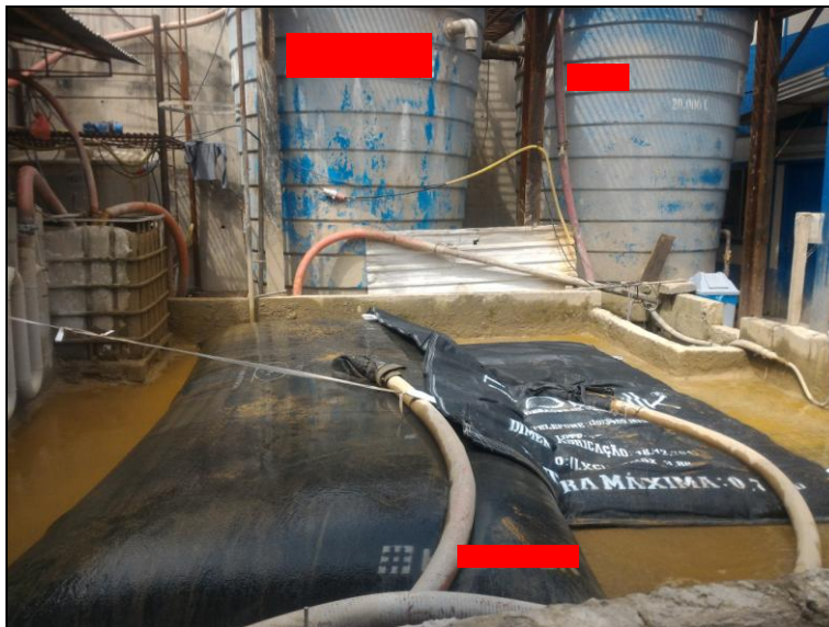
Figura 6 - Elementos do sistema de drenagem do lençol freático
