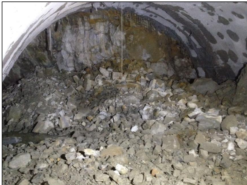
Figura 35 - Desmonte de rochas da frente de escavação
