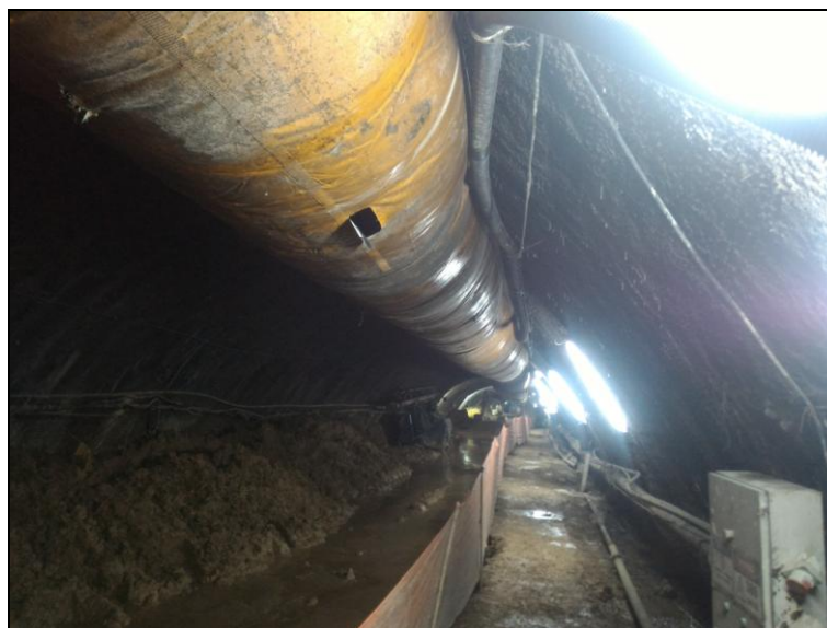
Figura 79 - Rasgo no duto de ventilação
