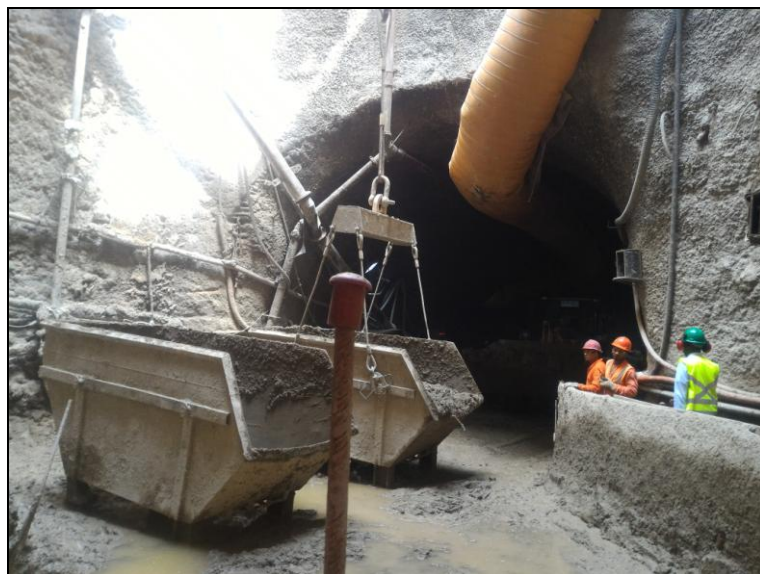
Figura 13 - Entrada do túnel (caminho segregado para os trabalhadores à direita)
