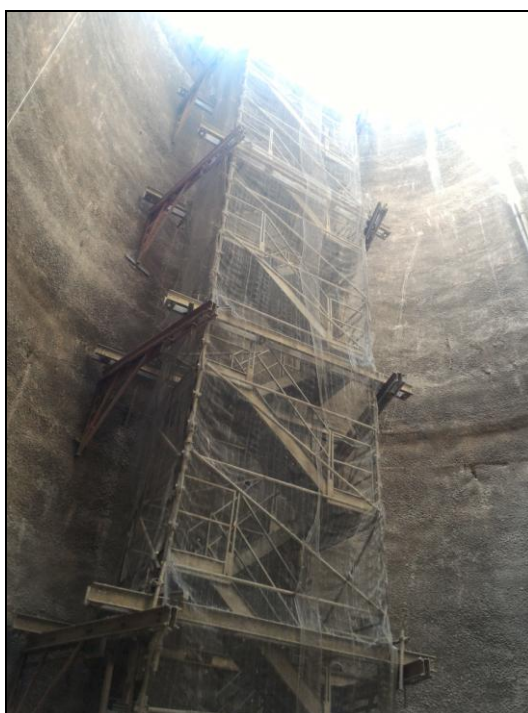
Figura 11 - Plataformas metálicas de acesso ao túnel
