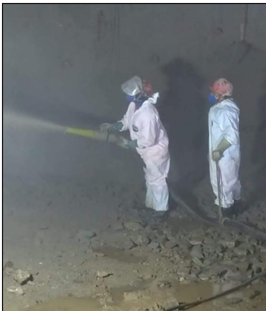
Figura 47 - Aplicação do concreto projetado
